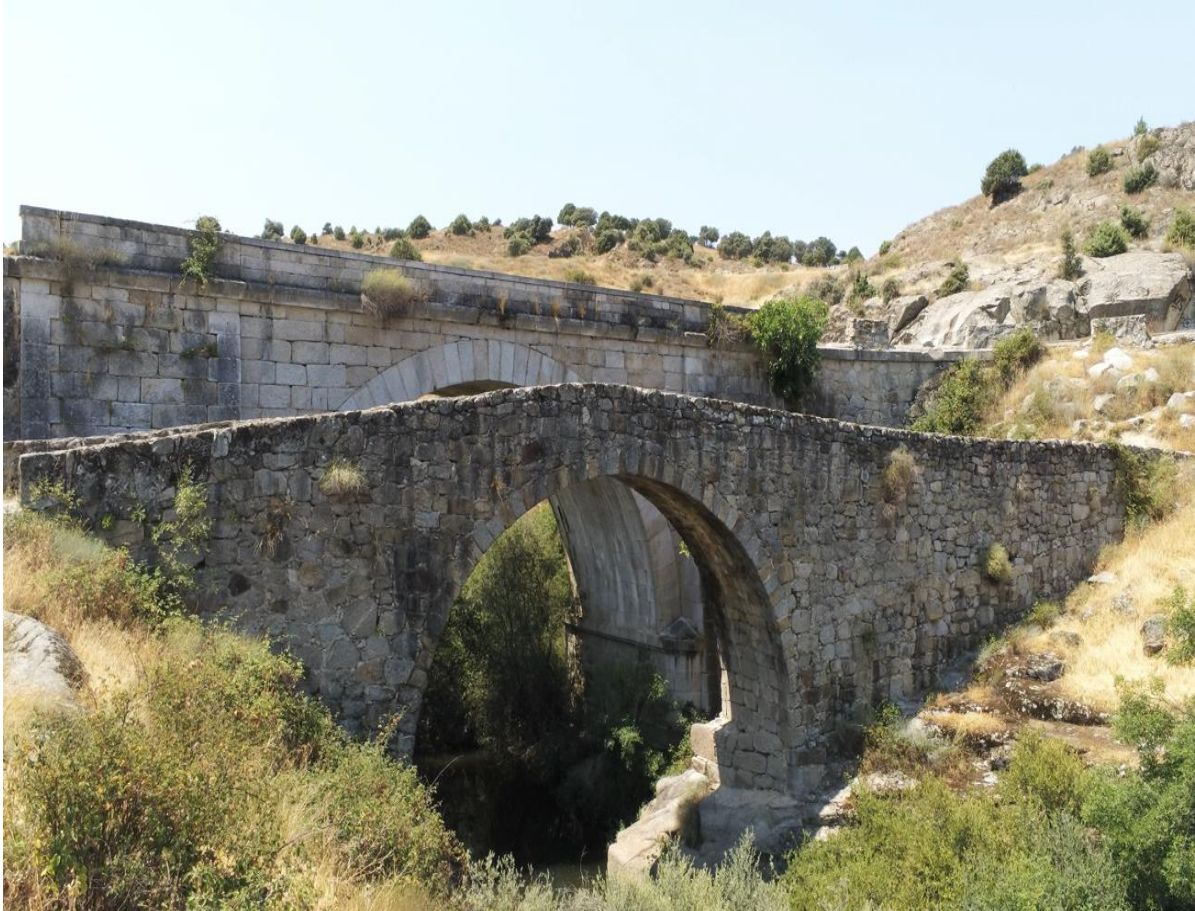
Figure 1: Photographie prise avec le drone utilisé dans l'inspection, où l'on peut voir le pont médiéval de Grajal, élévation nord, avec le pont du XIX e siècle derrière (photographie de l'auteur).
